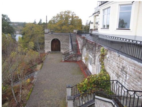
Del av terrasanläggningen. (Byggnad nummer 5)
