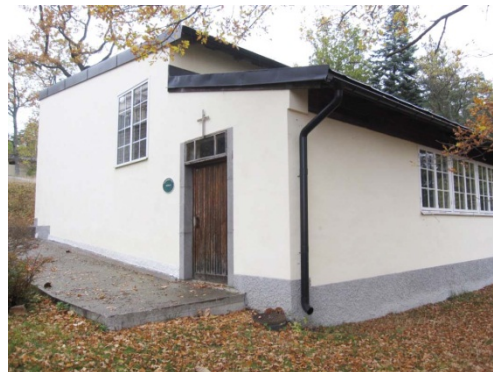
Kyrkan sydost om huvudbyggnaden. (Byggnad nummer 6)
